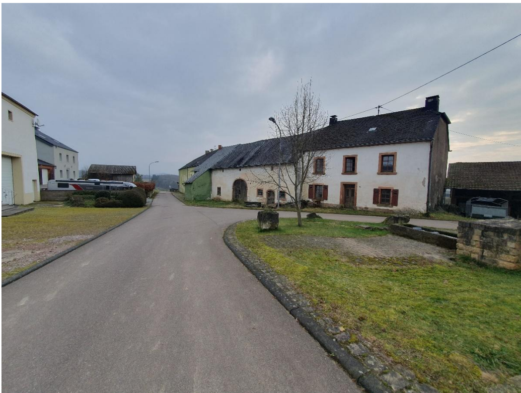
Abb. 3: Standort Im Weg, Foto: Ingenieurbüro P & P GmbH
