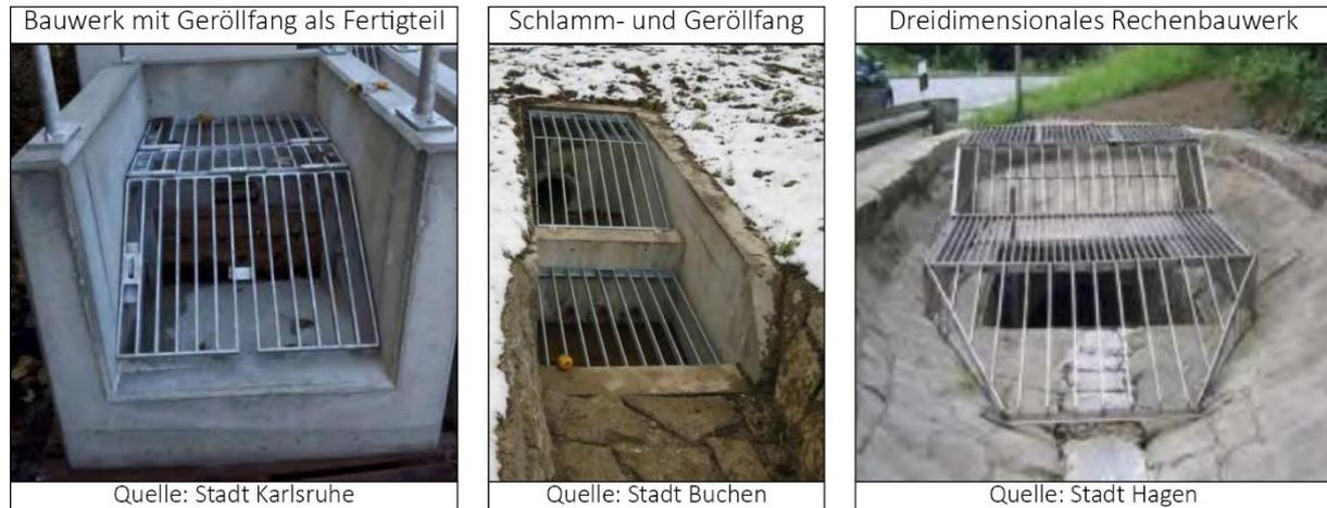
Neben der baulichen Ausführung ist zudem wichtig zu beachten, dass sich die Bauwerke gut unterhalten und reinigen lassen und auch im Ereignisfall noch Maßnahmen zur Freihaltung und Räumung des Bauwerks möglich sind.
