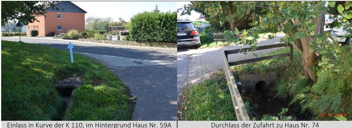
Entlang der Verbindungsstraße zwischen der K 110 in Obersöst und der K 124 (Richtung Fisch) befinden sich beiderseits Halbschalen in den Wegeseitengräben, die vor der K 110 zusammengeführt werden und das Wasser durch Roste in den Kanal einleiten.
