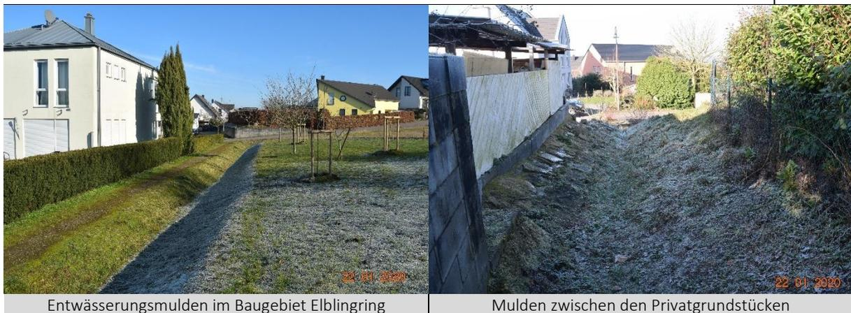
Im Baugebiet Elblingring sind Entwässerungsmulden zwischen den Grundstücken angelegt worden, um das Niederschlagswasser zu bewirtschaften. Die Mulden und insgesamt die Entwässerung ist jedoch nicht mehr durchgängig funktionsfähig, da die Vorrichtungen durch die Anlieger mitunter zugeschüttet wurden oder innerhalb des Grundstücks mitbenutzt werden, sodass auch eine regelmäßige Unterhaltung nicht möglich ist.
