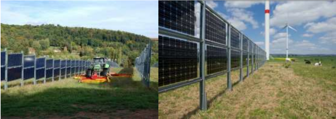
Abbildung 4: Darstellung einer vergleichbaren Agri-PV Anlage mit Mahd sowie Pilotanlage mit Beweidung (Fotos: Next2Sun GmbH)
