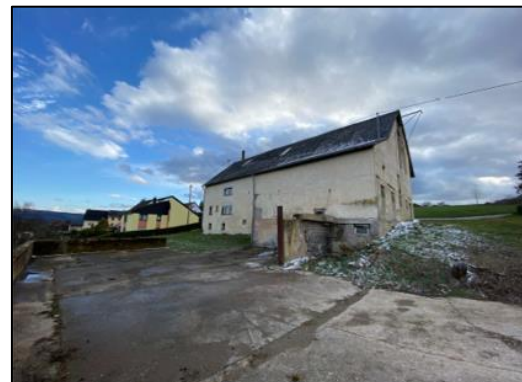
Rückwärtige Ansicht / Hof
