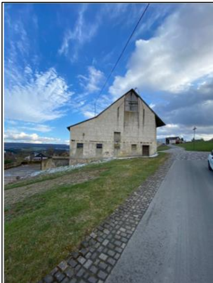
Abb. 3: Ansicht von Nordosten, von Zum Weiherdamm
